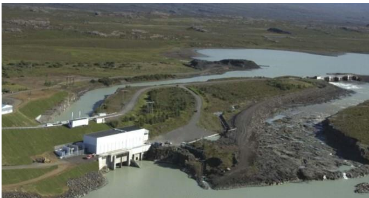
Pogled na strojnico HPP Lagarfoss
