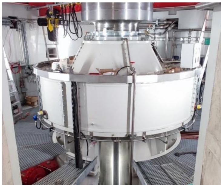
Pogled na tretjo enoto med montažo
