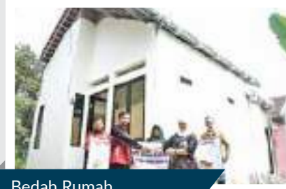
Bedah Rumah House Renovation
