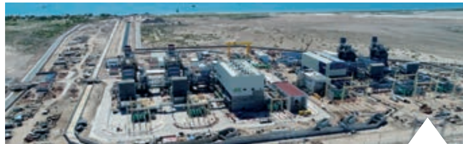
Central de ciclo combinado de Empalme I (México) / Empalme I combined cycle plant (Mexico).
