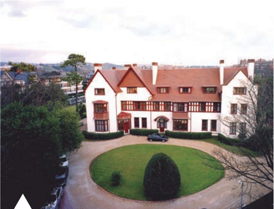
Oficinas de SENER en Bilbao (España) / SENER offices in Bilbao (Spain).
