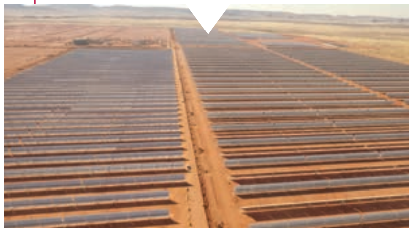
Obras en Ilanga 1 (Sudáfrica) / Construction works in Ilanga 1 (South Africa).
