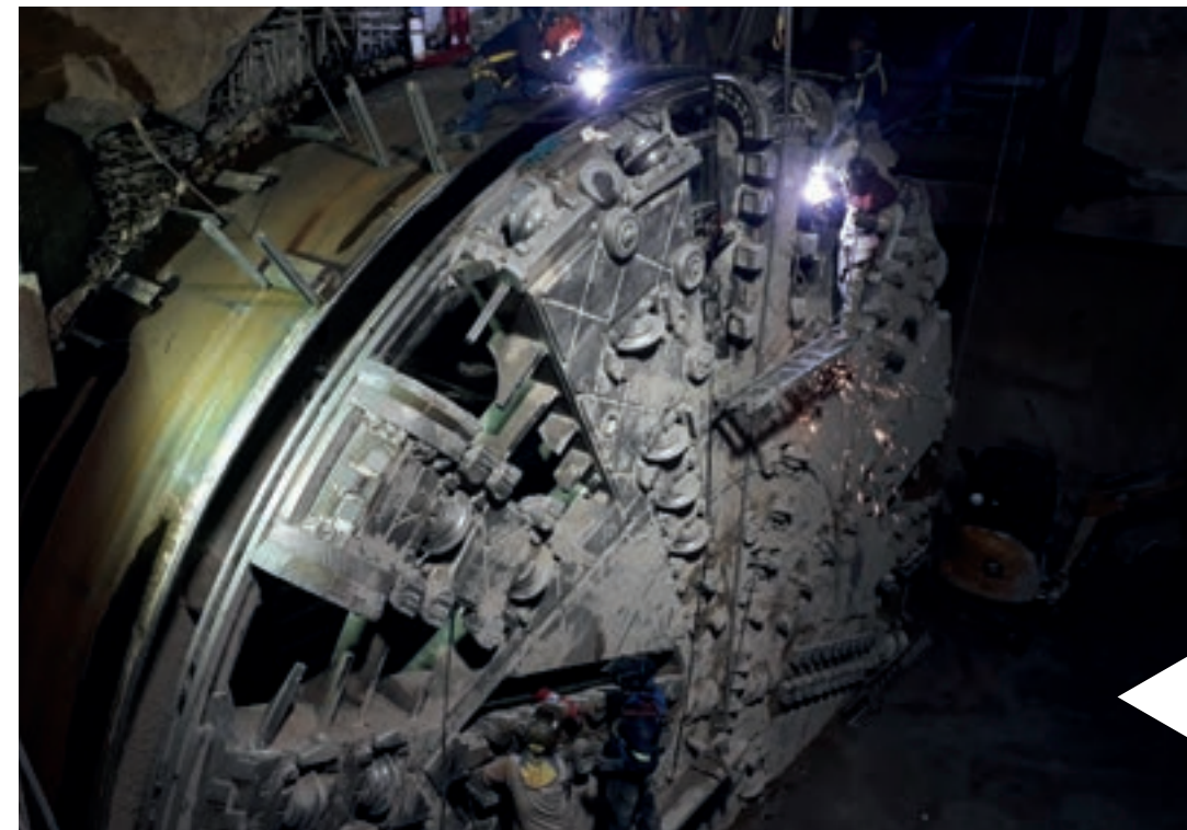
Trabajos de la tuneladora de la línea 3 del tren ligero de Guadalajara (México). Tunnel boring machine works on the line 3 Guadalajara light rail system (Mexico).
