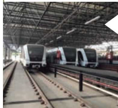
Obras de la línea 3 del metro de Guadalajara (México) / Works on the Guadalajara metro line 3 (Mexico).
