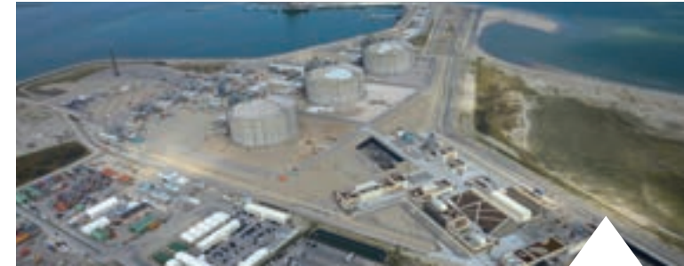
Planta de regasificación de GNL de Dunkerque / Dunkirk LNG regasification plant.
