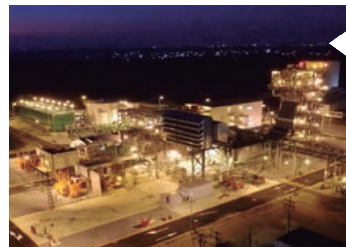
Central de cogeneración eficiente de energía Afrañrent (México). Afrañrent efficient cogeneration plant (Mexico).
