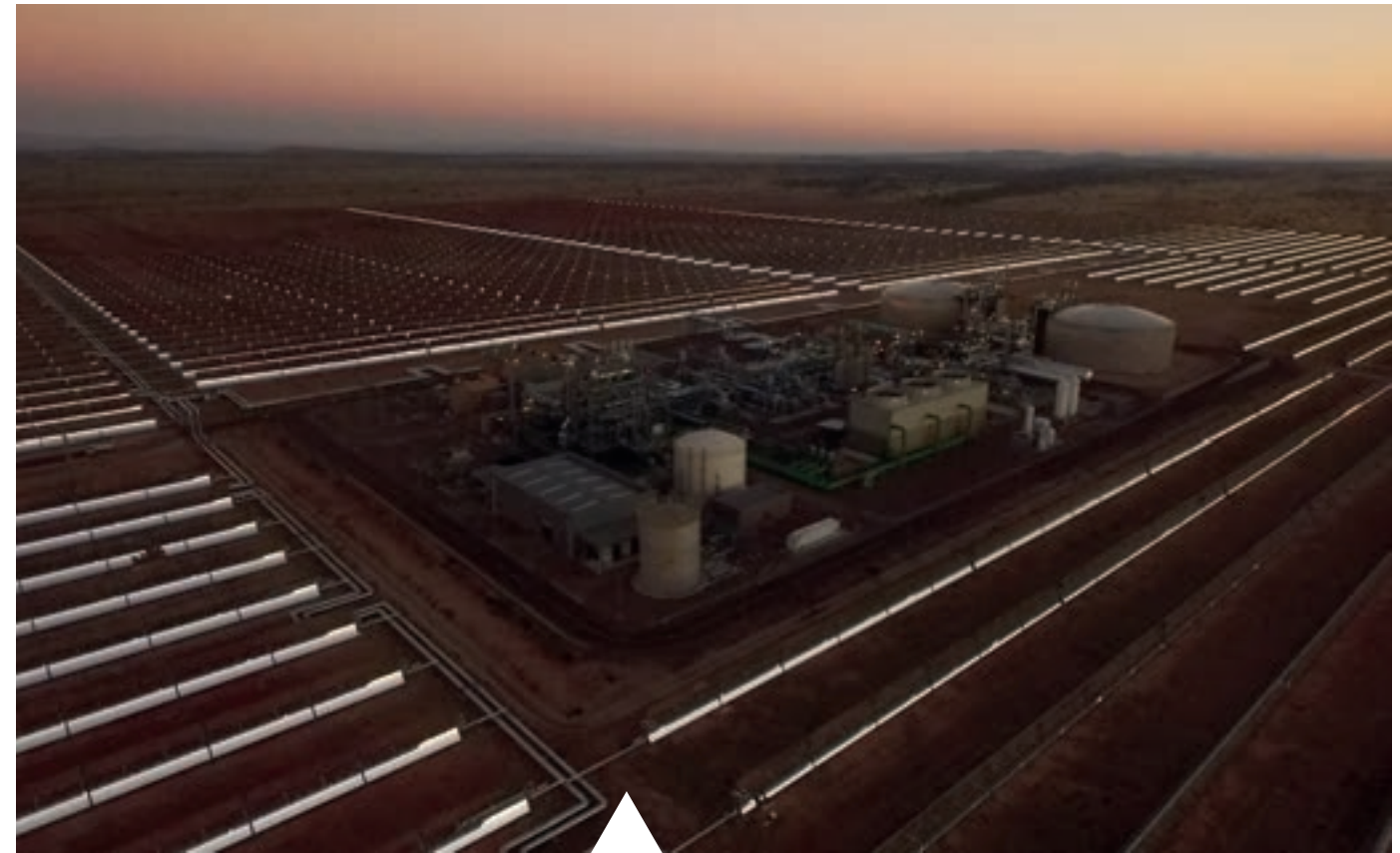
Vista aérea de la planta solar termoeléctrica Bokpoort (Sudáfrica). Aerial view of Bokpoort solar thermal power plant (South Africa).
