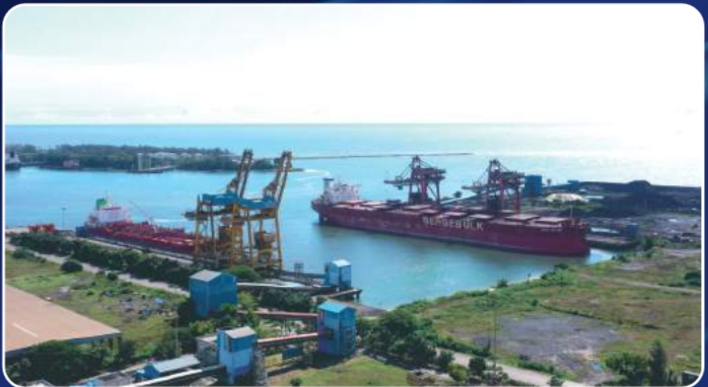
मशीनीकृत कोयला हैंडलिंग Mechanized Coal handling
